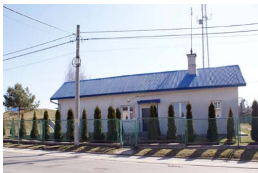
Stacja wodociągów ze zbiornikiem wyrównawczym przy ul. Rataja w Ropczycach
