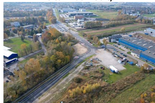
Rozbudowa ul. Przemysłowej
