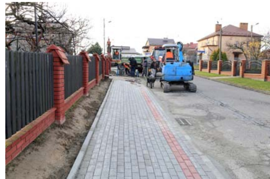
Budowa chodnika (ul. Pułaskiego)
