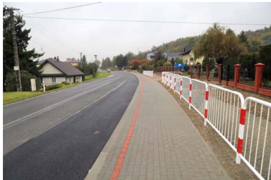
Budowa chodnika przy DW986
